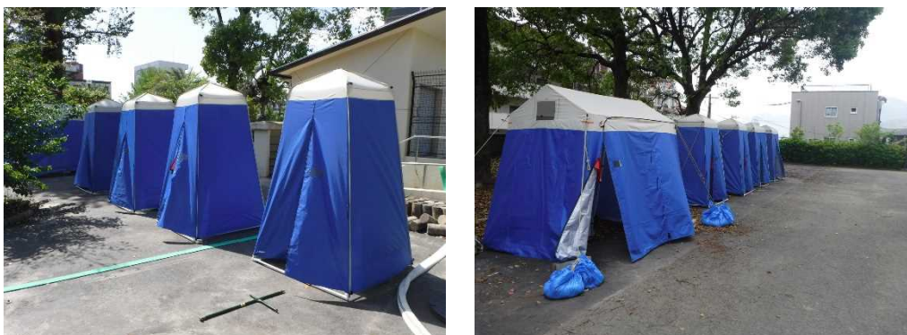
マンホールトイレ設置状況
