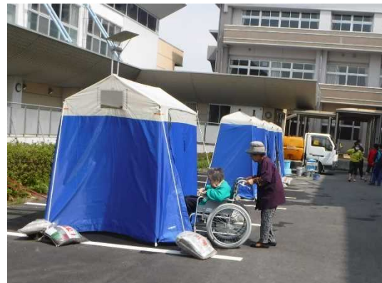
写真 1-1 熊本市で使用したマンホールトイレ
