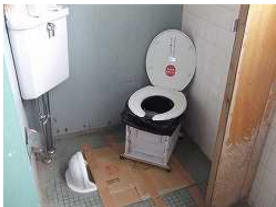
写真 2-3 使用不可のトイレブースを工夫して利用 (提供: 特定非営利活動法人日本トイレ研究所)
